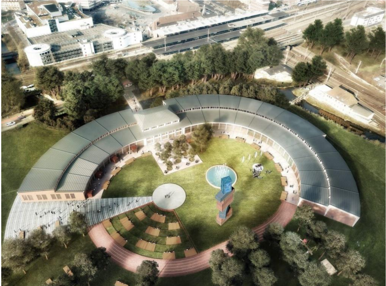
Coppenrath Innovation Center im ehemaligen Ringlokschuppen des Güterbahnhofsareals © Lok Viertel OS GmbH
