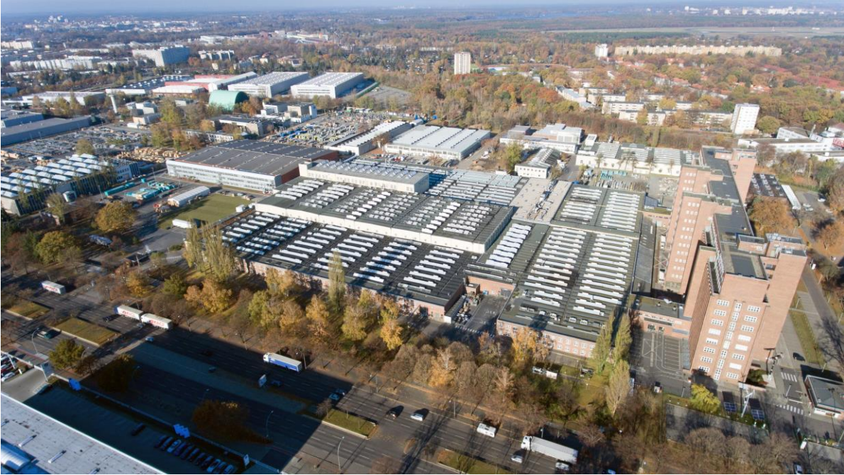
Bestandssituation (Quelle: Siemens AG)
