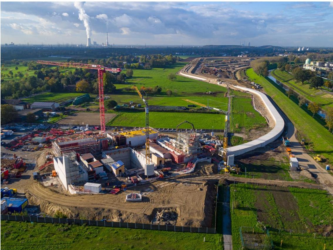
Pumpwerk Oberhausen mit hochliegendem Abwasserkanal Emscher
