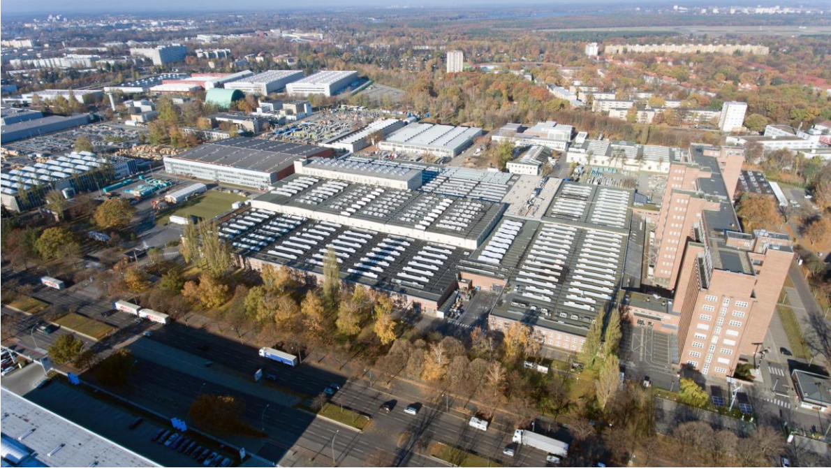
Bestandssituation (Quelle: Siemens AG)
