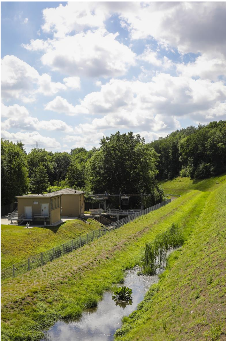
Blick bachaufwärts auf den Schurenbach entlang der Emscherstraße am Schurenbach-Pumpwerk, ökologische Verbesserung von km 0,00 bis km 1,73 in Essen und Gelsenkirchen. Foto: Rupert Oberhäuser
