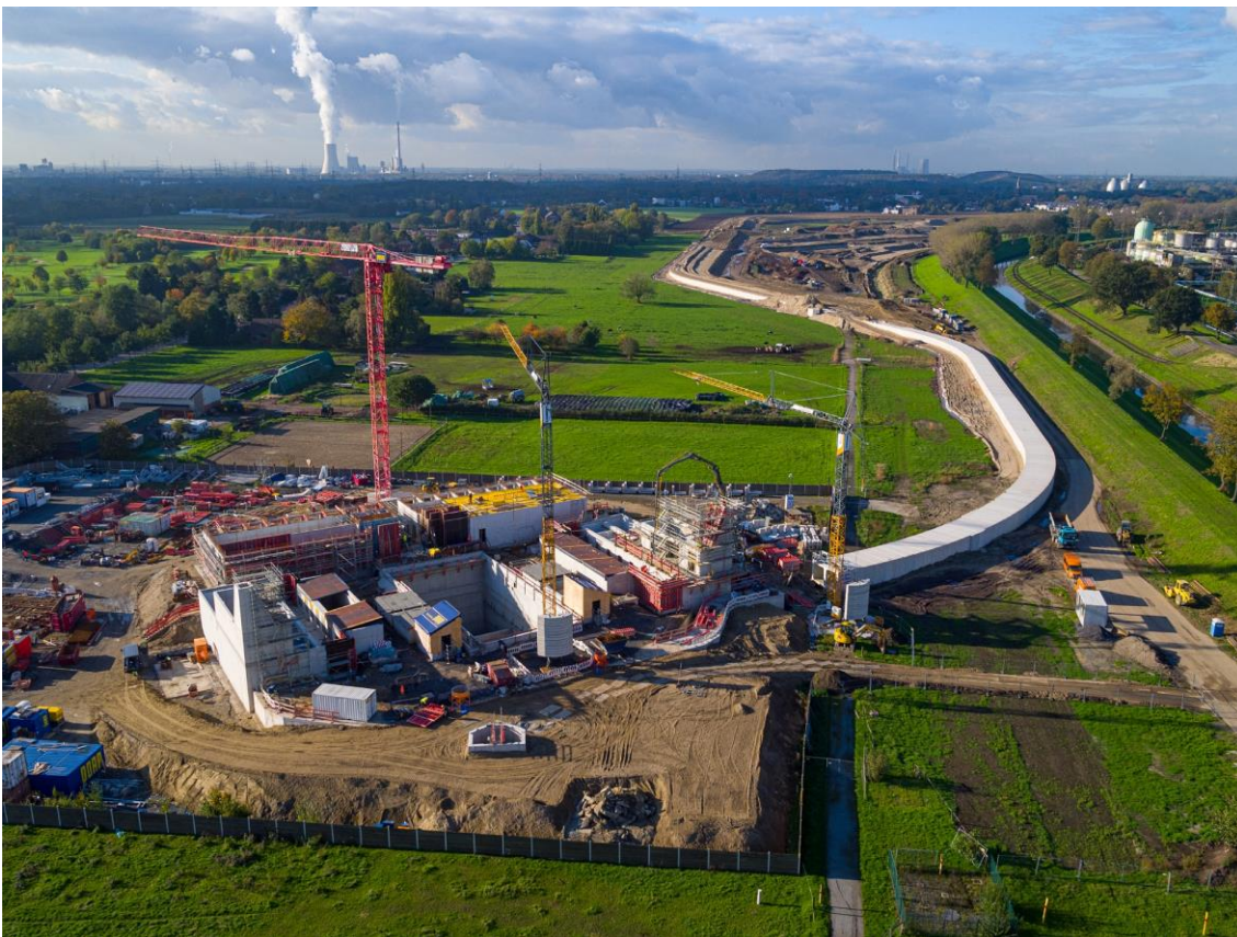
Pumpwerk Oberhausen mit hochliegendem Abwasserkanal Emscher Fotograf: Markus Greulich
